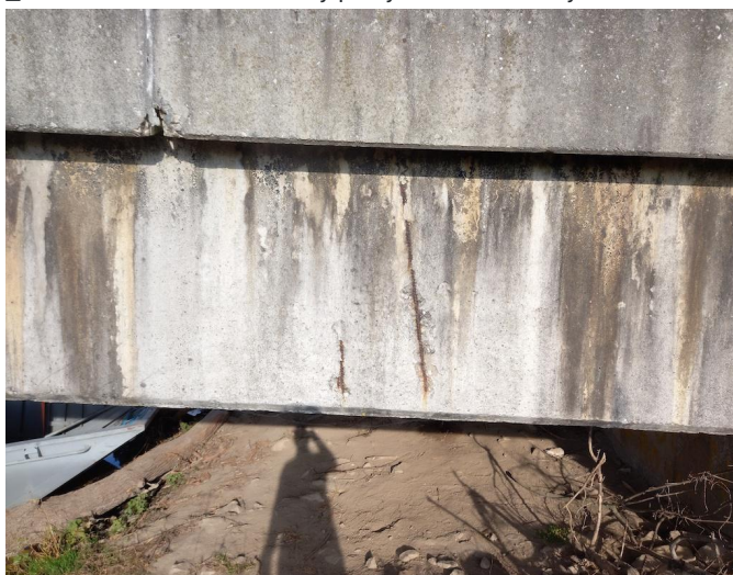
_111541 - stopy po zatékání na boční plochy nosné konstrukce, místy obnažená výztuž, prozatím patrná
