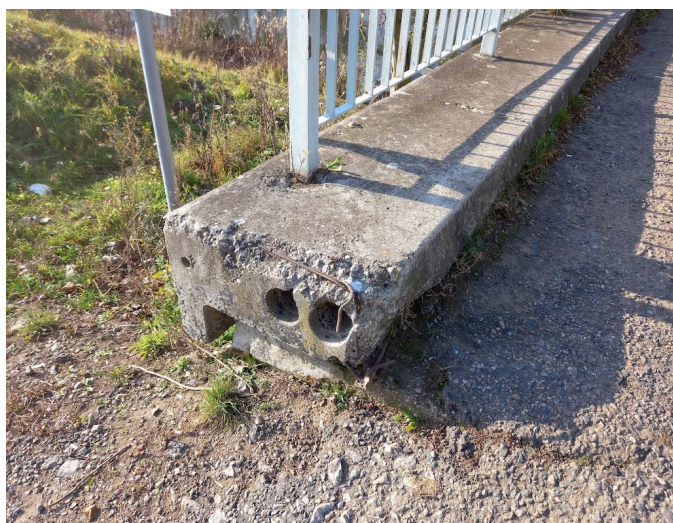
_110321 - degradace povrchu římsy na začátku mostu vlevo
