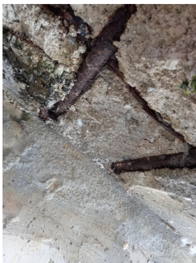
_114907 - na podhledu NK se lokálně vyskytují stopy po zatékání, obnažené třmínky, napadené korozí
