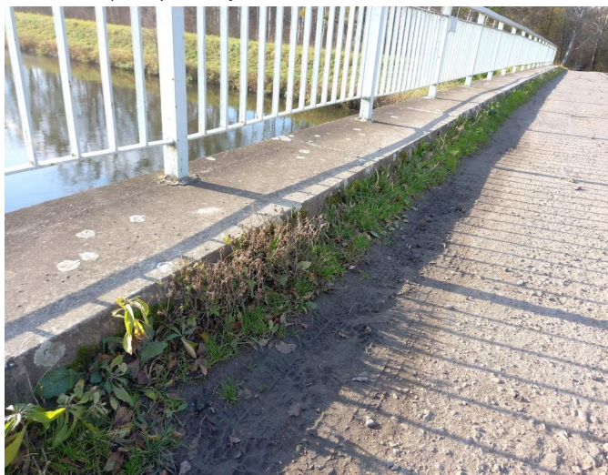
_110442 - podél říms je uchycená vegetace, spára je netěsná (zdroj zatékání)
