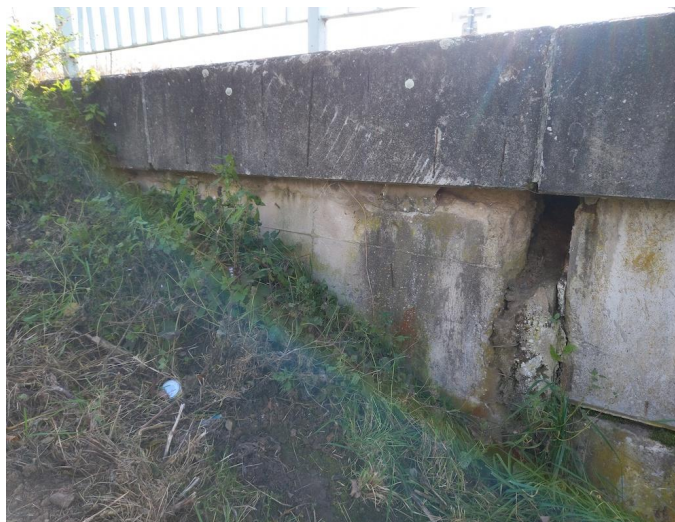
_111657 - zasypaná dilatační spára na začátku mostu !
