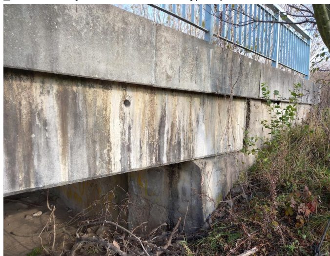
_111536 - stopy po zatékání na boční plochy nosné konstrukce, místy obnažená výztuž, prozatím patrná
