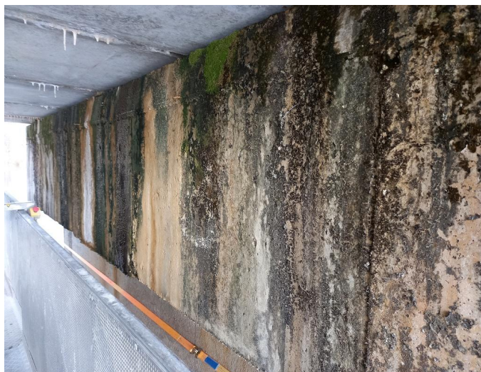
_114836 - masivní zatékání na povrchy pilířů v místech mostních závěrů
