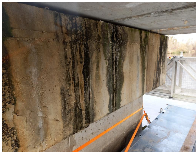
_114051 - masivní zatékání na povrchy pilířů v místech mostních závěrů
