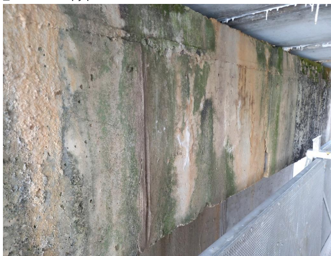
_115448 - masivní zatékání na povrchy pilířů v místech mostních závěrů
