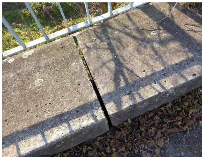
_110401 - tmel spár říms ztrácí přilnavost k povrchu betonu i svoji konzistenci, ve sparách je míst
