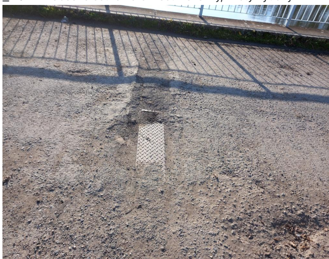
_110133 - nad pilířem P2 je obnažená konstrukce podporchového mostního závěru
