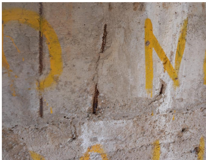
_111743 - lokálně obnažená výztuž na povrchu opěry O1 (nedostačené krytí)
