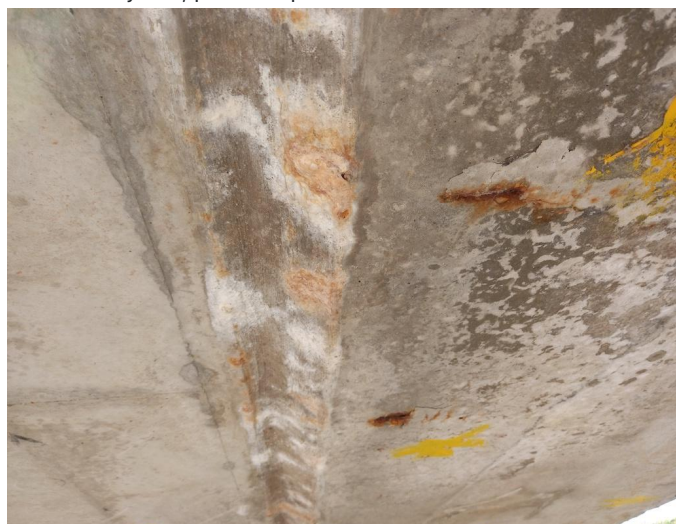
_111608 - na podhledu NK se lokálně vyskytují stopy po zatékání, obnažené třmínky, napadené korozí
