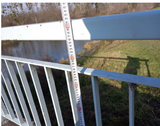
_110649 - PKO zábradlí je lokálně porušená, prozatím bez větší koroze
