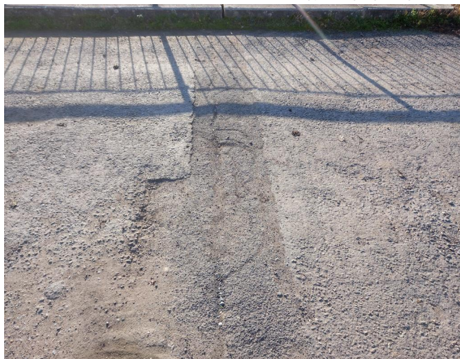
_110224 - nad opěrou O4 je otevřená příčná trhлина vozovky
