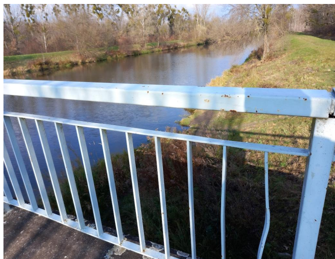
_110712 - místy deformované svislé výplně pravého zábradlí
