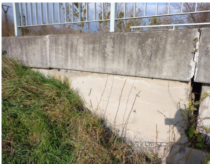
_112719 - nečistoty na úložném prahu opěry O4
