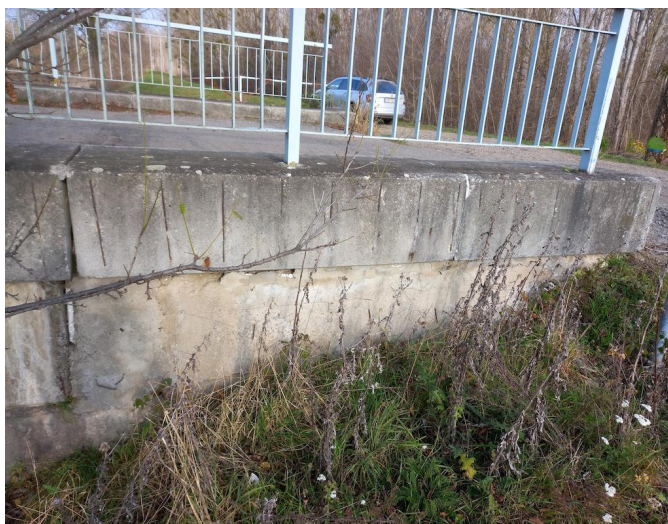
_111512 - na levé římse místy prorýsovaná svislá výztuž
