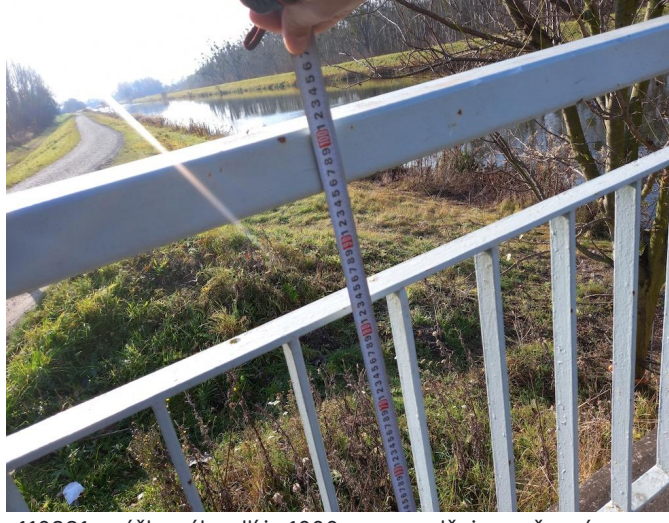
_110331 - výška zábradlí je 1000mm, nesplňuje současné normové požadavky
