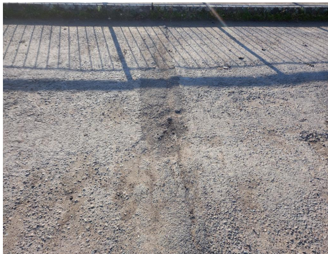
_110200 - nad pilířem P3 je otevřená příčná trhлина vozovky
