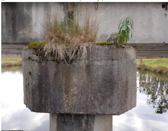
_115915 - uchycená vegetace na površích pilířů
