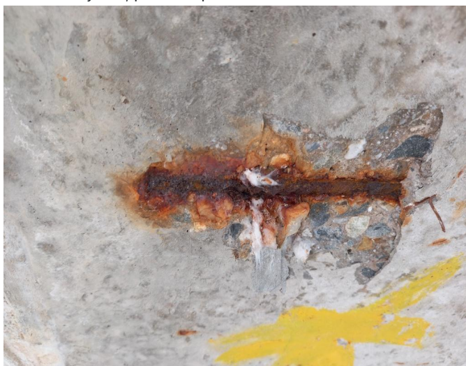
_111618 - na podhledu NK se lokálně vyskytují stopy po zatékání, obnažené třmínky, napadené korozí
