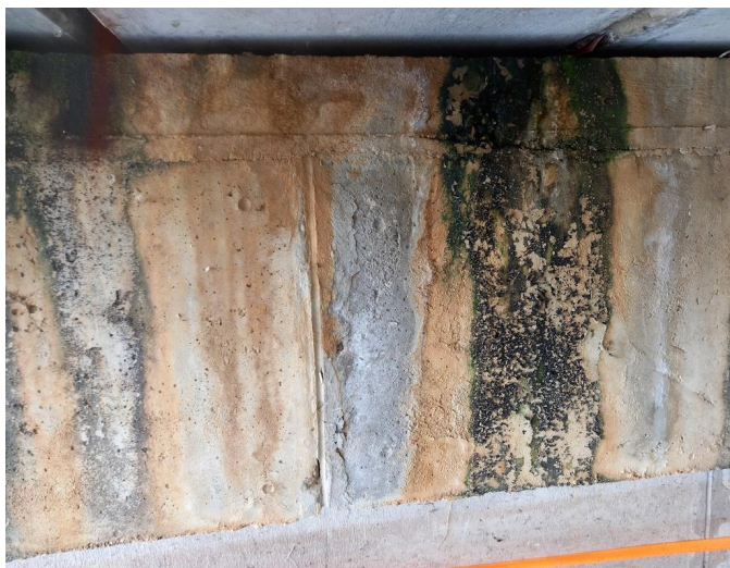
_114125 - masivní zatékání na povrchy pilířů v místech mostních závěrů
