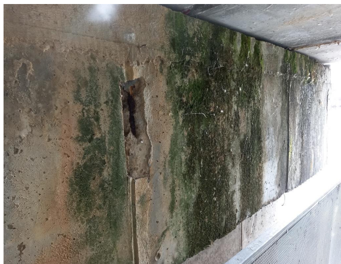
_120118 - lokálně obnažená výztuž pilíře P3
