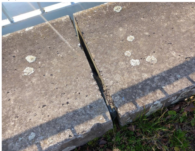
_110514 - tmel spár říms ztrácí přilnavost k povrchu betonu i svoji konzistenci, ve sparách je míst
