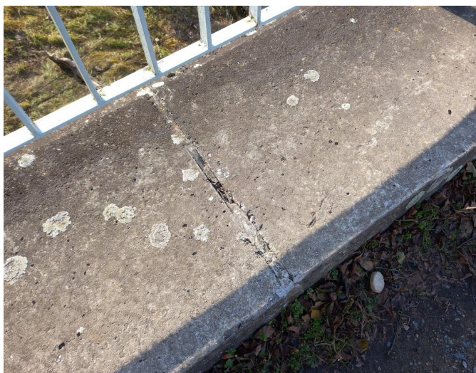
_110409 - tmel spár říms ztrácí přilnavost k povrchu betonu i svoji konzistenci, ve sparách je míst
