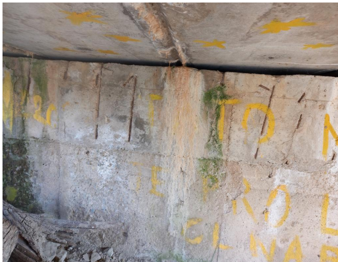
_111736 - lokálně obnažená výztuž na povrchu opěry O1 (nedostačené krytí)
