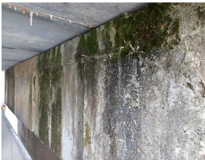
_120131 - masivní zatékání na povrchy pilířů v místech mostních závěrů
