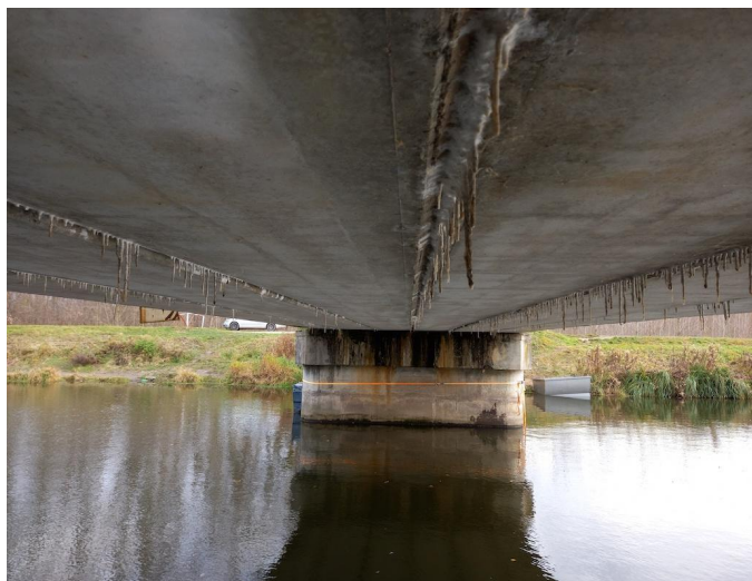
_115352 - stopy po masivním zatékání do nosné konstrukce
