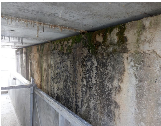
_115419 - masivní zatékání na povrchy pilířů v místech mostních závěrů
